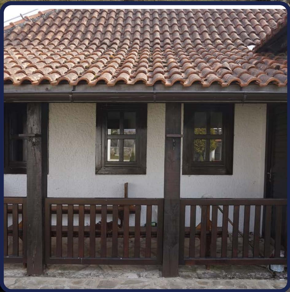
Završna obrada vrši se sistemom vazdušnog prskanja sa nadpritiskom,renomiranog Italijanskog proizvođača ICA, impregnacijom u tonu prema TON karti i transparentnim lakovima posljednje generacije na bazi vode, ili impregnacijom i pokrivnim lakovima na bazi vode u tonu po RAL karti, koji obezbeđuju kvalitetnu zaštitu i jednostavno održavanje.
